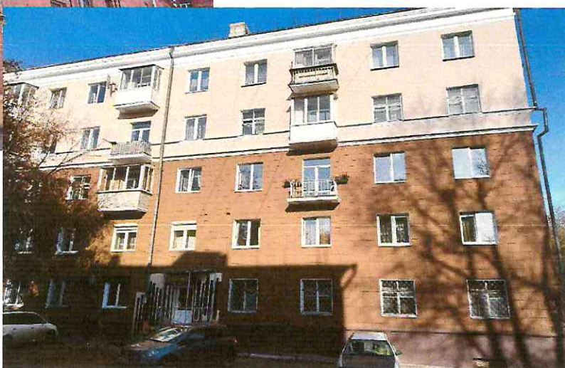
Ремонт фасада, г. Иркутск, 2-я Железнодорожная ул., д. 6
