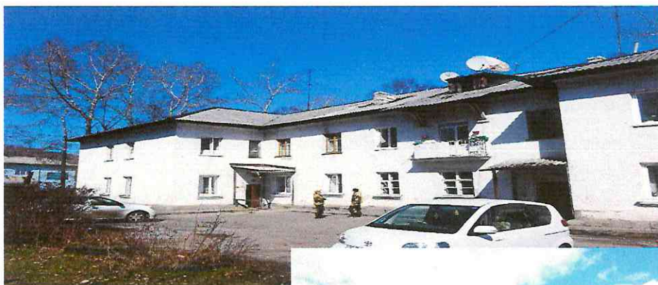
Ремонт фасада, г. Слюдянка, Ленина ул., д. 12
